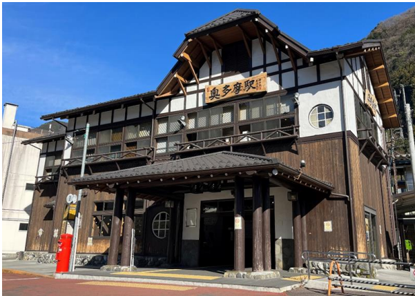
山小屋風の奥多摩駅舎
