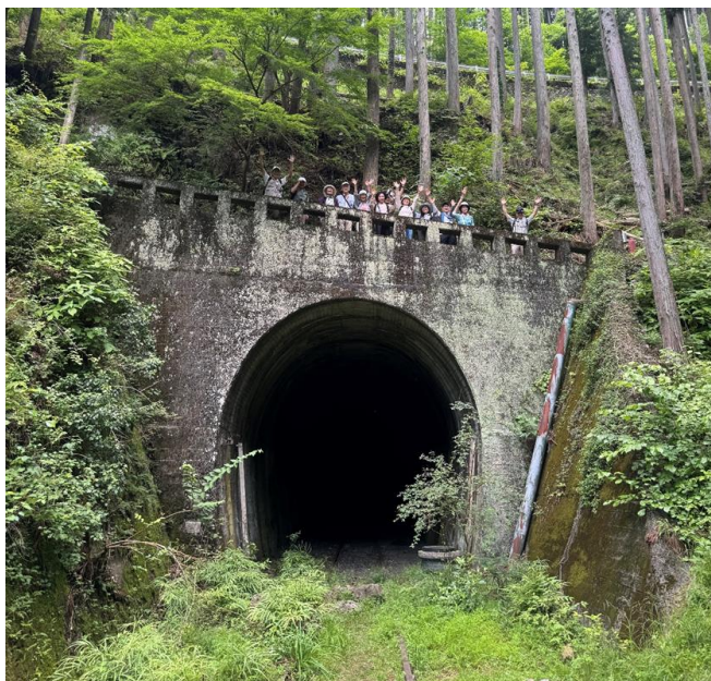
貨物線跡のトンネルの上で手を振るみなさま
