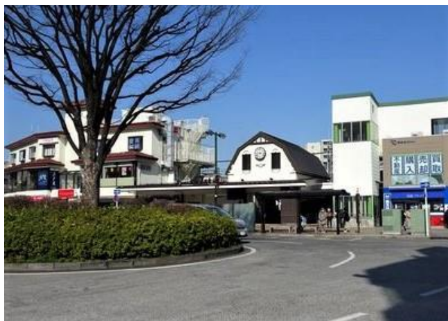
小田急線向ヶ丘遊園駅南口駅舎（写真：浅黄）
